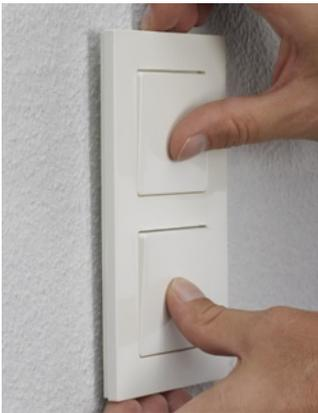
Wippe und Rahmen werden zu einer Einheit zusammengeschnappt. Aufstecken der Kombination Wippe/Rahmen auf den Geräteinsatz – Fertig.
